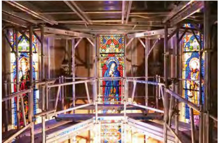
Echafaudage à l'intérieur de la chapelle.
