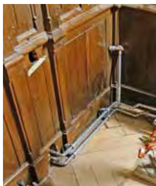
Alimentation des radiateurs en eau chaude.
