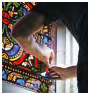
Préparation 1:1 d'une pièce de remplacement sur un vitrail à « fabriquer » en atelier.
