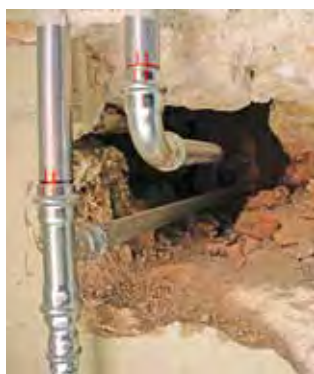
Alimentation des radiateurs en eau chaude.
